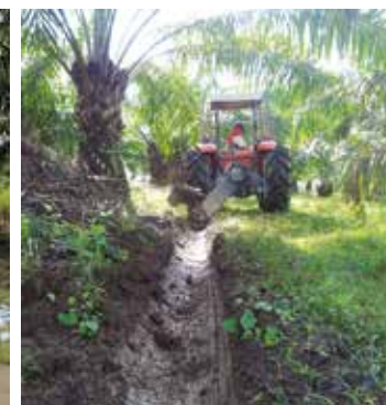
Después del drenado con ditcher . Foto: G. Enríquez
