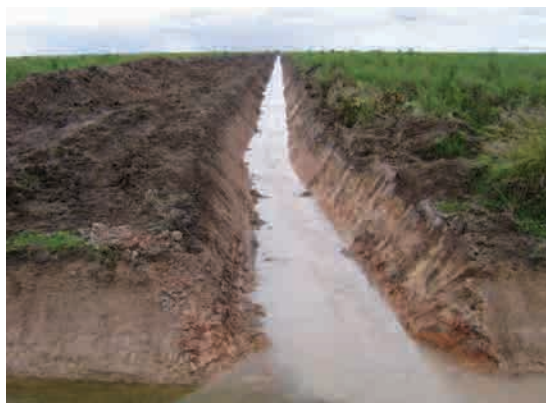
Figura 18. Construcción de drenajes antes de la siembra.
