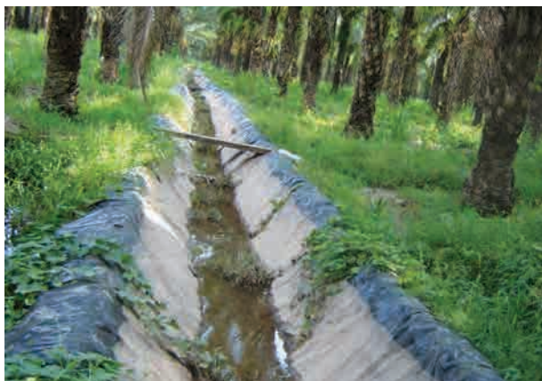
Figura 77. Canales de riego revestidos con plástico.
