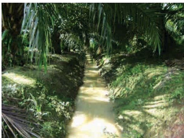
Figura 33. Drenaje interno funcional.
