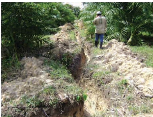
Figura 47. Drenajes mal construidos.
