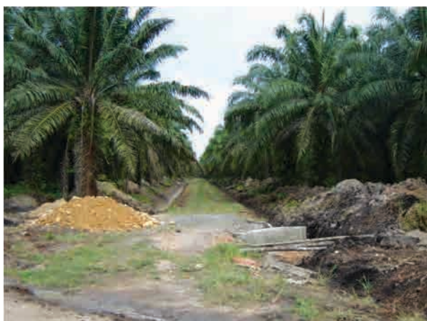
Figura 34. Drenaje externo funcional.
