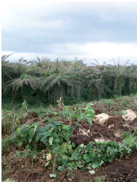
□ Eliminación de palmas con excavadora.
