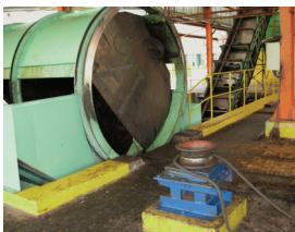
Volteo de vagonetas esterilizadas
