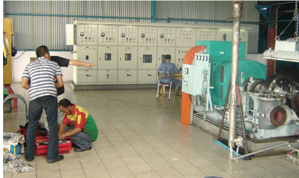
Mantenimiento de una turbina a contrapresión
