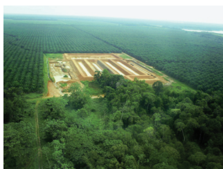
Construcción de lagunas
