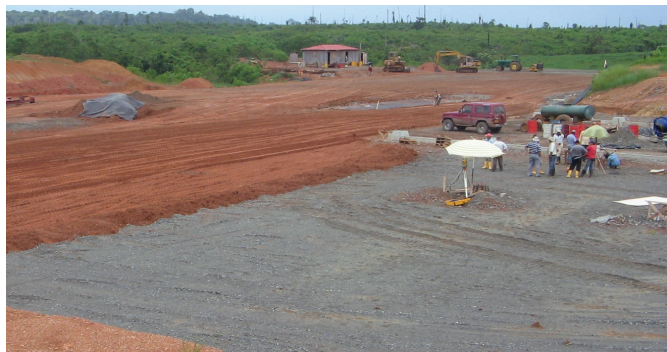
Obras civiles de adecuación del terreno para la construcción de una planta extractora
