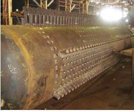
Fabricación domo de vapor de una caldera
