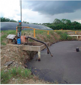
Bombeo de lodos
