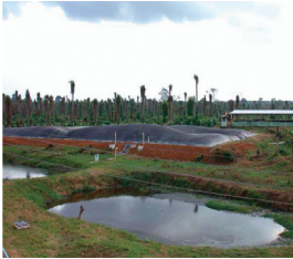
Sistema de tratamiento de aguas residuales
