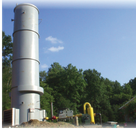
Generación de calor y vapor
