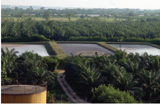
Laguna de estabilización
