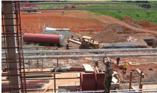
Montaje de una planta extractora
