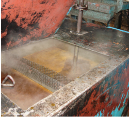
Condensados en el sistema de esterilización vertical
