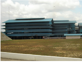
Vista exterior de una planta extractora
