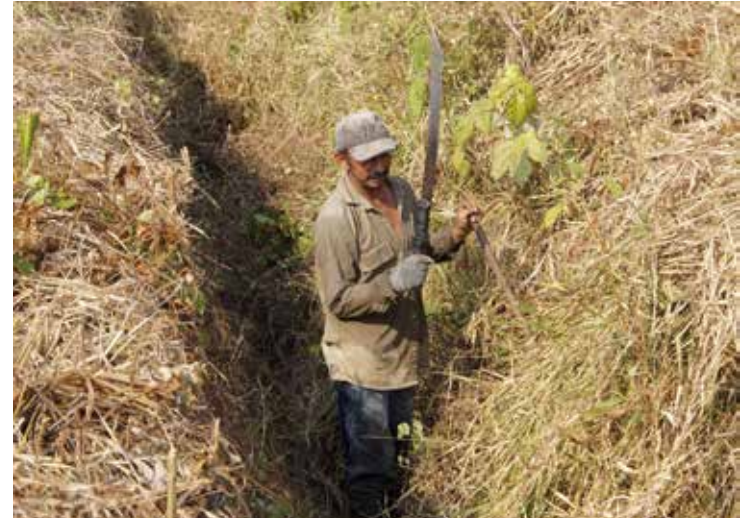
Figura 30. Rocería manual de drenajes.
