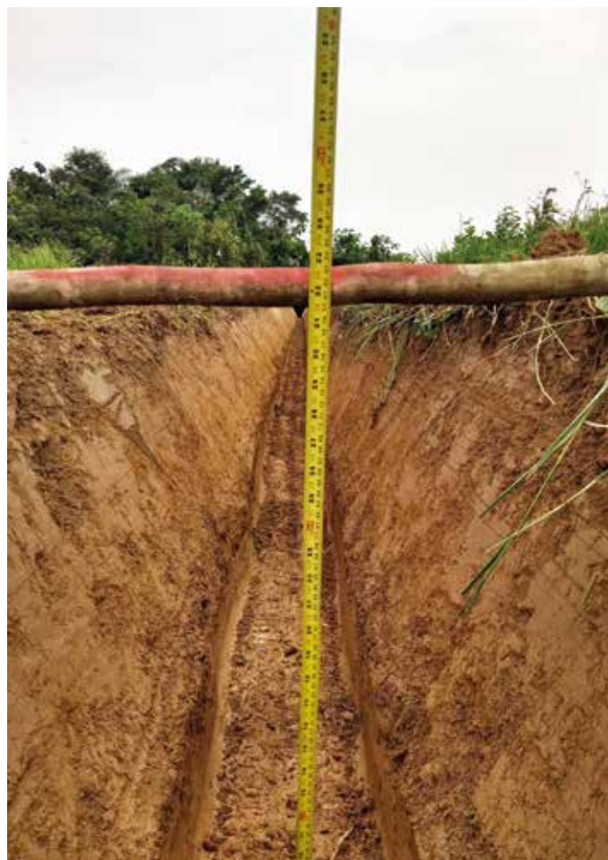
Figura 40. Verificación de profundidad del canal según perfil de nivelación.
