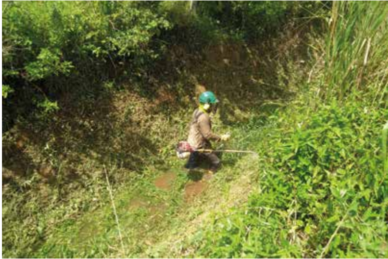
Figura 29. Control de malezas en taludes de canales de drenaje con guadañadora.
