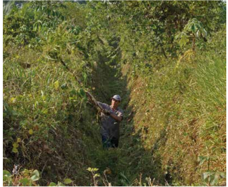
Figura 36. Operario retirando malezas y sedimentos con pala desde el interior de un canal.
