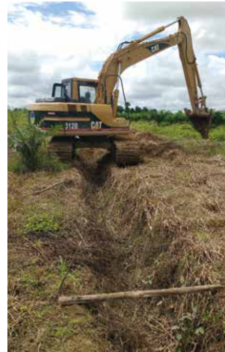
Figura 39. Pala excavadora realizando mantenimiento correctivo de canales de drenaje.
