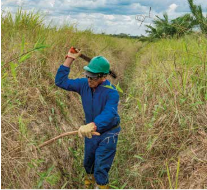
Figura 35. Operario controlando malezas en el interior de un canal con machete (mano derecha) y garabato (mano izquierda).
